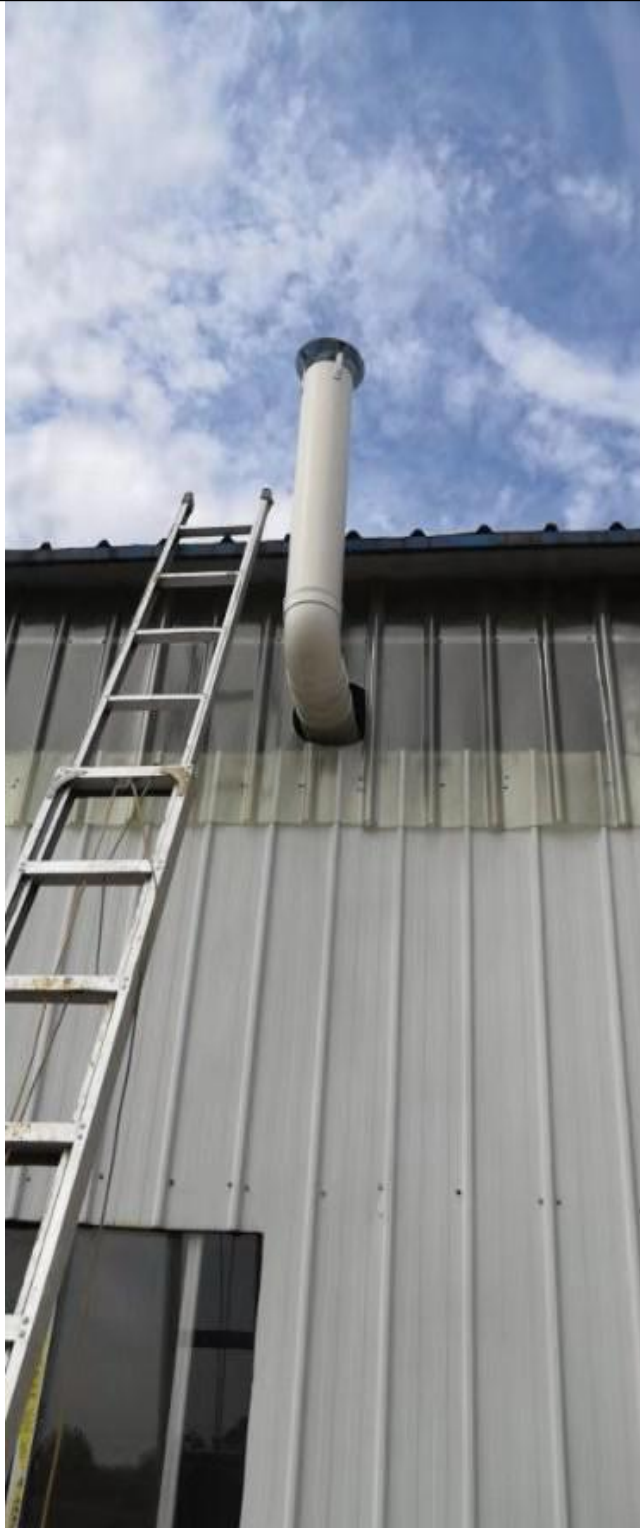
布袋除尘装置+15m 高排气筒
